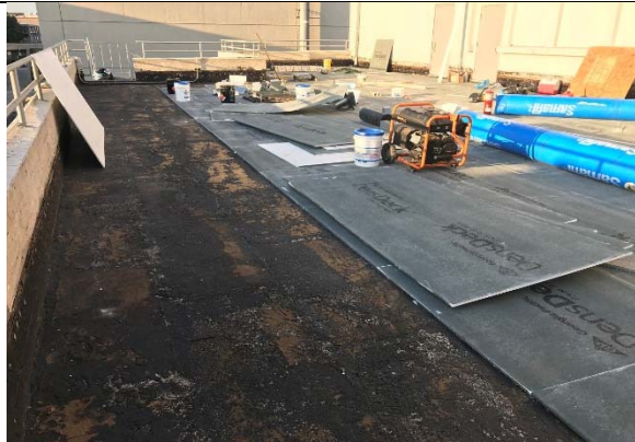
Inglewood Juvenile Center - Inglewood - Roof
