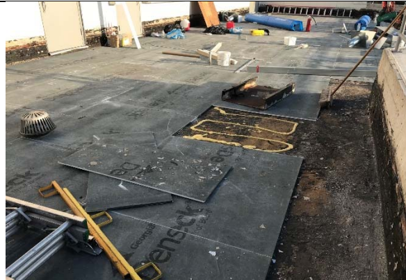
Inglewood Juvenile Center - Inglewood - Roof
